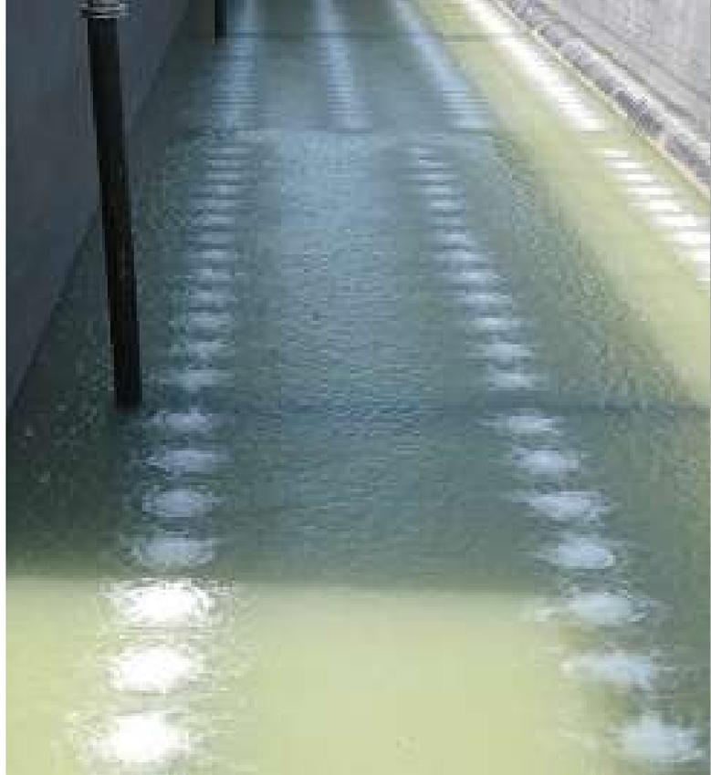
Системы аэрации на основе торообразных аэраторов AP-500T с эластичной перфорированной мембраной предназначены для аэрации иловой смеси в системах биологической очистки сточных вод.
