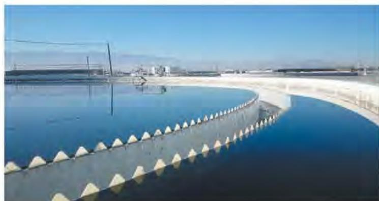
**Материал изготовления - нержавеющая сталь или специальный листовой пластик, устойчивый к ультрафиолету и низким температурам.**
