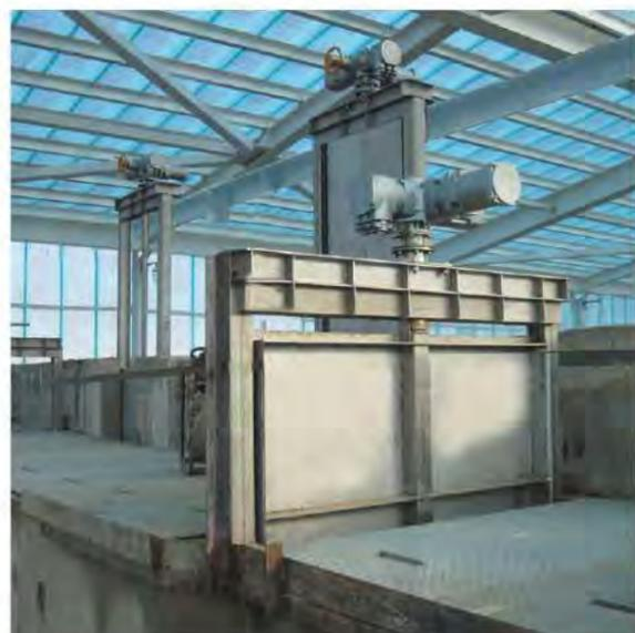
**Простота замены уплотнителя, подшипников, винта и ползуна винтовой передачи производится без демонтажа рамы затвора.**
