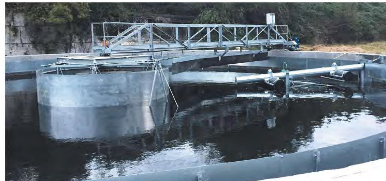
**Инновационная и эффективная система сбора плавающих веществ, которая обеспечивает равномерный сбор и удаление плавающих веществ по всему радиусу отстойника.**
