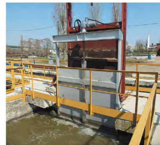
**Все затворы «Экополимер» изготавливаются из нержавеющей стали и других коррозионностойких материалов.**
