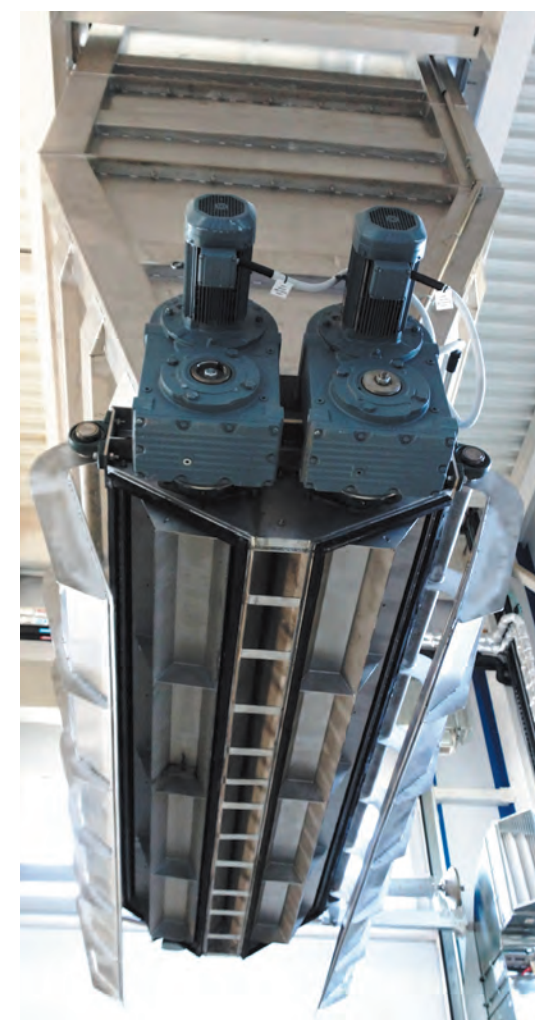
Бункер для накопления 48 м³ кека с лопастным ворошителем-дозатором и ковшевым затвором.
